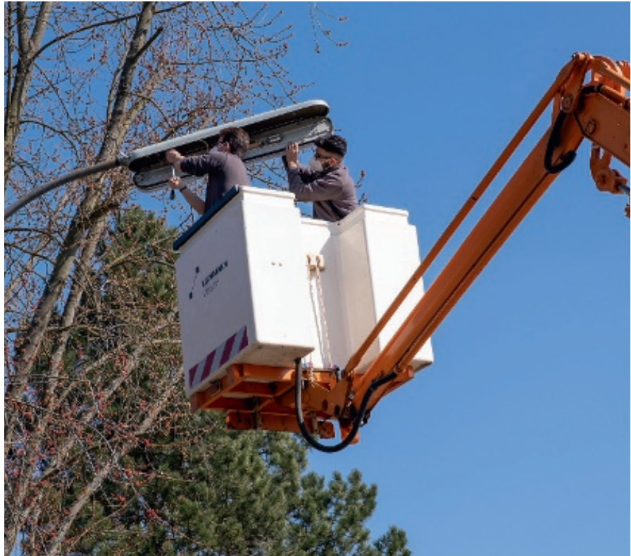
Stück für Stück werden die alten Lichtmaste demontiert.
