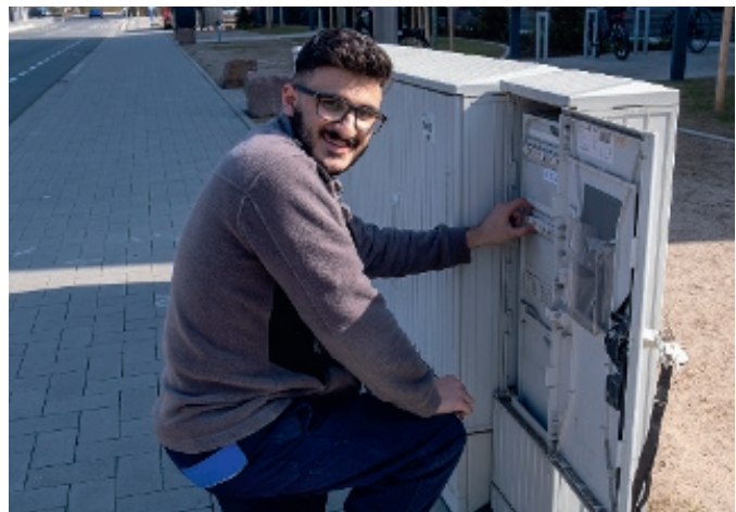
Der Schalter fällt: die alten Beleuchtungsmaste werden vom Netz genommen.
