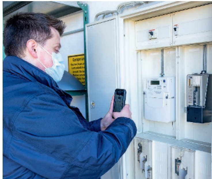
Der elektronische Zähler wird über einen QR-Code ausgelesen.
