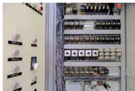
Ein Blick in den Schaltschrank: Die alte Relais-technik und die neue digitale Technik.
