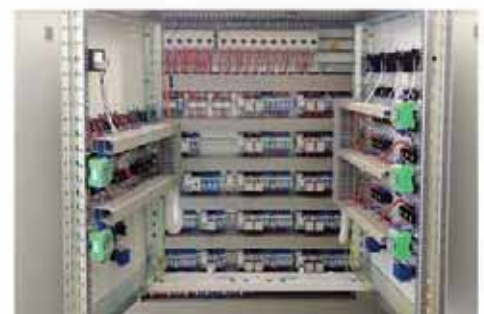
Ein Blick in den Schaltschrank: Die alte Relais-technik und die neue digitale Technik.
