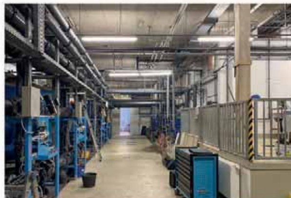
Blick in die unterirdische Halle mit der Freibadtechnik.
