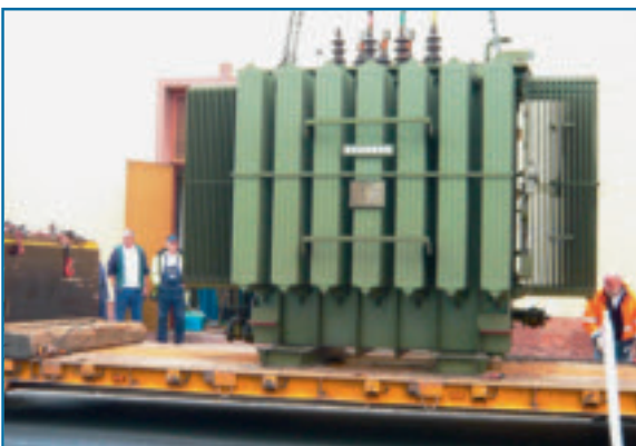
Es ist vollbracht. Der Trafo steht sicher auf dem Tieflader. Gut zu erkennen: Die Rippen des Kühlkörpers, die ein wenig an einen Heizkörper erinnern.
