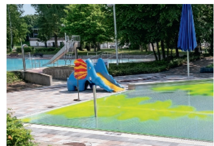
Die Chlorung des Wassers verhindert Keimbildung.
