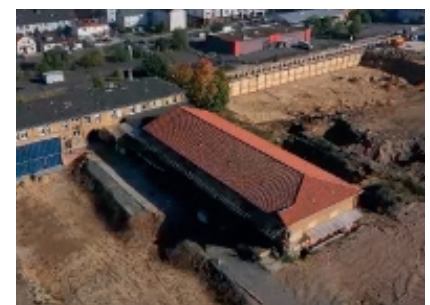
Moderne Technik: Drohnenaufnahmen vom Baugelände.
