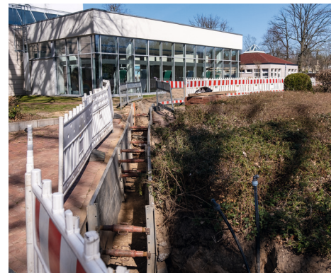
Eine neue Reinwasserleitung von rd. 60 m versorgt das Planschbecken mit frischem Wasser.
