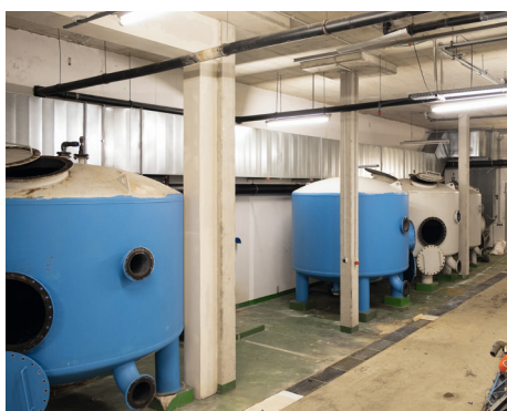
Eine fast leere Halle (l.): Acht riesige neue Mehrschichtfilter stehen in einer Reihe.
