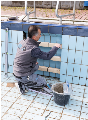
Die Fliesen werden passgenau eingeklebt.
