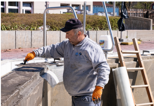
Der Beckenkopf wird für das Fliesen bereit gemacht.
