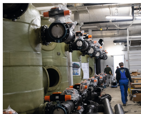
Eine fast leere Halle (l.): Acht riesige neue Mehrschichtfilter stehen in einer Reihe.
