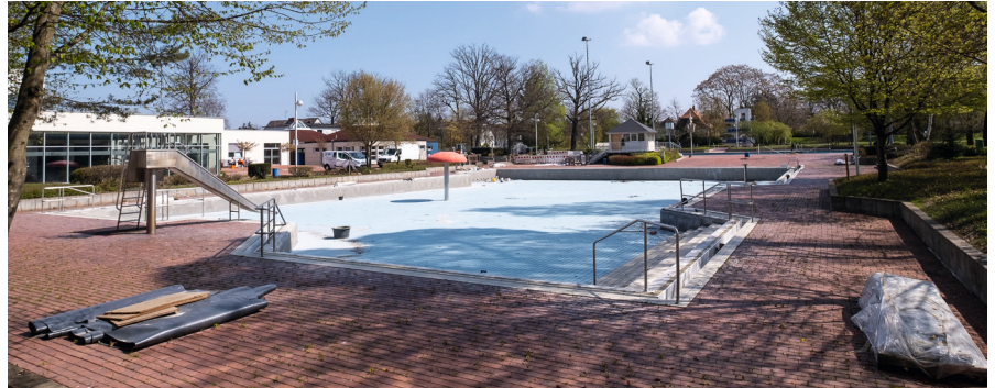
Großbaustelle Freibad: Überall wird gearbeitet.
