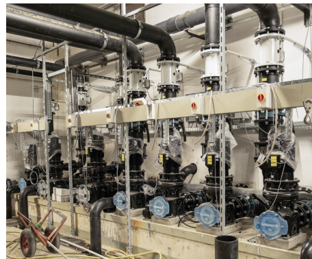
Die neuen Pumpen (r.) sorgen zukünftig für die Umwälzung des Beckenwassers & lösen die alten (l.) ab.
