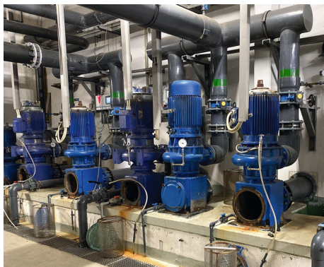
Die neuen Pumpen (r.) sorgen zukünftig für die Umwälzung des Beckenwassers & lösen die alten (l.) ab.
