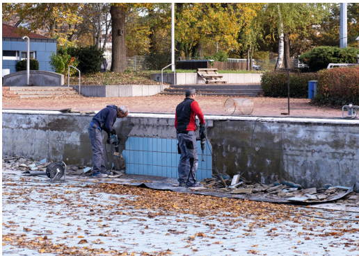
Die Fliesen werden mühevoll entfernt.
