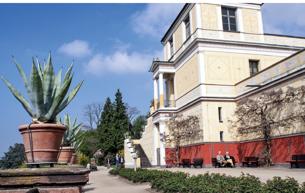
Außenansicht des Pompejanums
