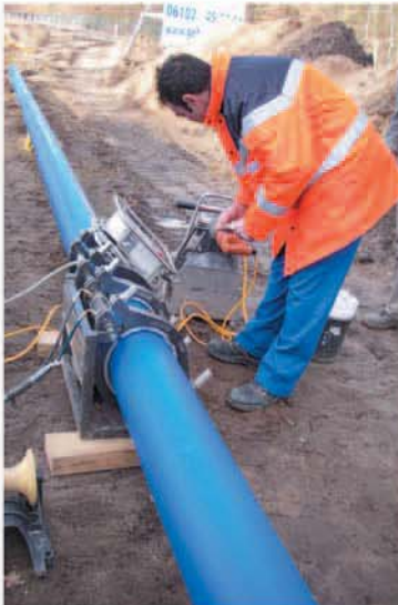
Fotos: Mitarbeiter der Stadtwerke beim schweißen der Gas- und Wasser PE - Leitungen.
