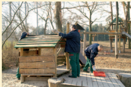
Die Spielplatzkolonne bei der Reparatur von Spielgeräten.
